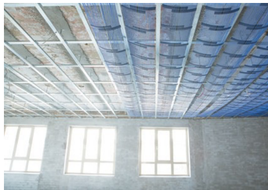
Isolation du plafond
