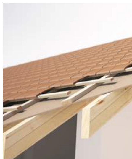
Dach vor der Renovierung (ohne Dämmung)
